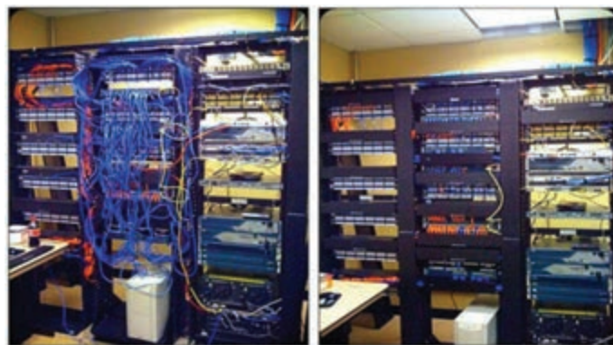
شکل ۴۱- مرتب کردن کابل‌ها
